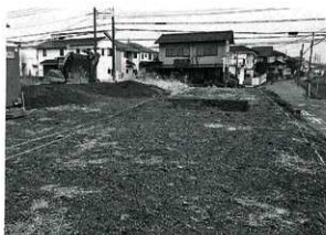
調査開始前状況（東から）
