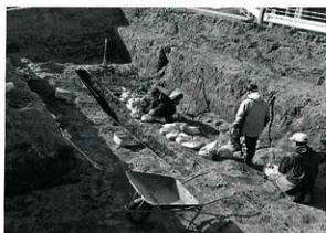
作業状況（南西から）
