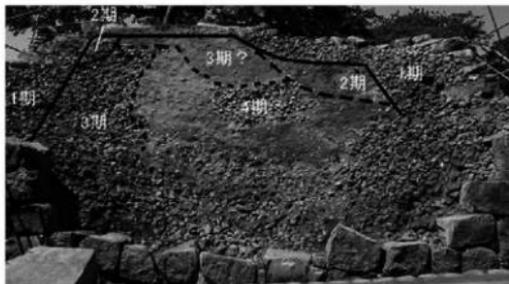
図Ⅲ-21 1工区石垣変遷概念図
