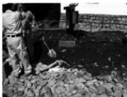
天端吸出し防止シート設置・表土埋戻し
