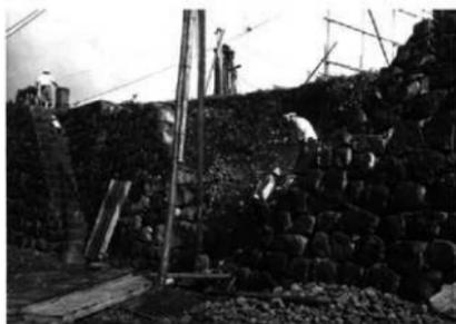
図II-10 昭和28年7月本丸鉄門東石垣工事
