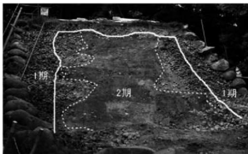
図Ⅲ-54 2工区石垣変遷概念図
