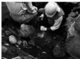
鏡石下築石上面合端合せ加工
