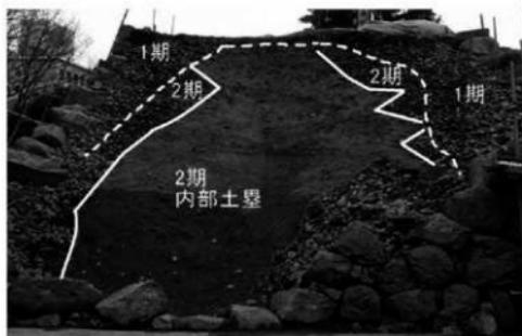
図Ⅲ-86 4工区石垣変遷概念図(東西断面)
