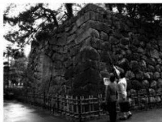
図II-3 1工区鏡石上部の孕み状況確認
