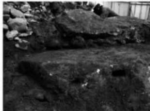
図Ⅱ-34 鏡石の右横石材の土目詰まり状況
