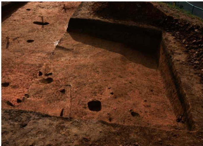
写真 24 南区 下層完掘状況 -北から-
