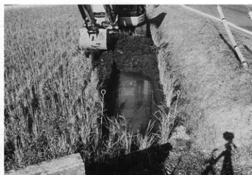
5. 3トレンチ調査風景 (南東から)
