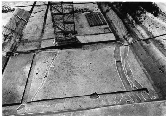
7区全景（北から）
