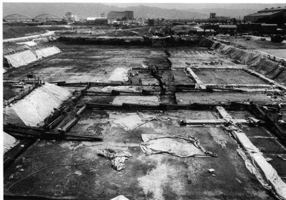
機械掘削の状況（西から）
