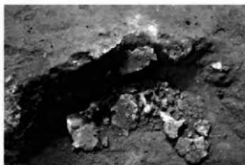
写真8 塩類析出による崩落
