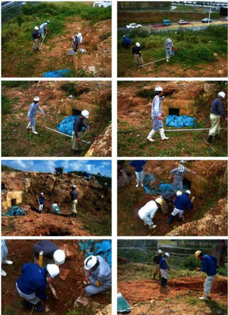
図版4 磁気探査業務の作業状況
