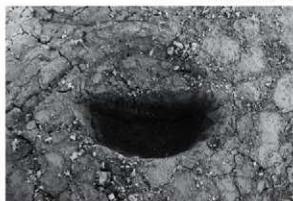
SP3 断面 (南西から)
