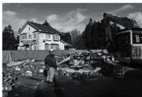
44 置賜学園東遺跡 工事立会 (南東から)
