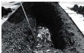
T1 全景 (西から)
