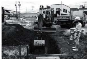
範囲②掘削作業状況(南東から)
