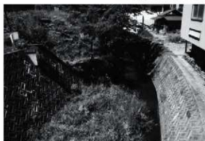
27 送橋川(下戸沢)河川整備単独事業(東から)
