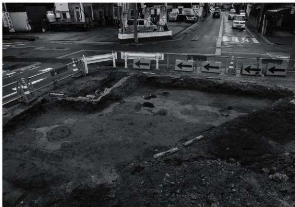
調査区全景遺構完掘状況 (南東から)
