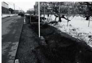
断面③付近確認状況 (南から)
