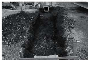
範囲①南側掘削完了状況(南から)
