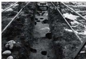
電気埋設管工事箇所南側遺構完掘状況 (南から)
