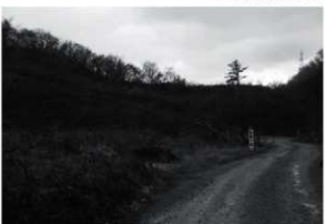
41 一般国道7号朝日温海道路(西から)
