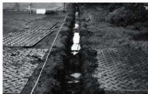
配管設置工事立会箇所掘削完了状況 (南東から)
