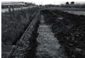
断面①付近確認状況 (南から)
