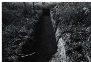
T 11 全景 (北から)
