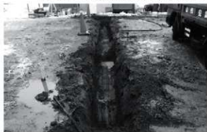
衛生配管設置工事立会箇所掘削完了状況 (西から)
