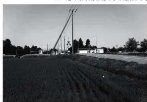
39 古館跡近接地工事立会箇所 (西から)
