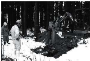
19 大沢第2道跡工事立会
