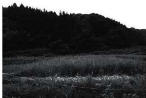
14 森林管理道念珠岡線開設工事(南西から)
