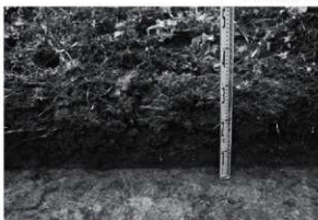
T 3 断面 (東から)
