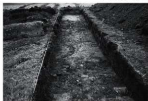
T 3 全景 (南東から)
