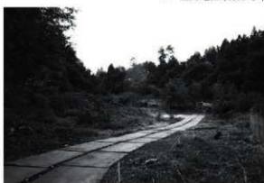
10 薬師山橋跡(北から)
