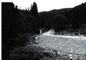
38 池の頭砂防堰堤工事 (北東から)
