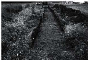
T 1 全景 (南から)
