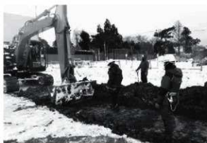
22 県立新潟工業高等学校体育館建設工事立会 (北西から)
