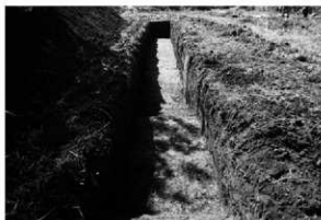
T 1全景 (南から)
