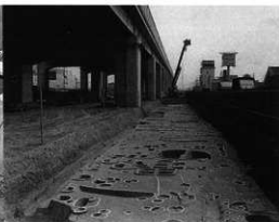
写真4 クレーン車による写真測量風景
