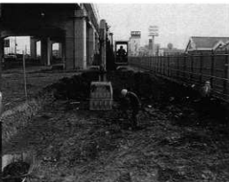
写真2 10F トレンチ機械掘削状況
