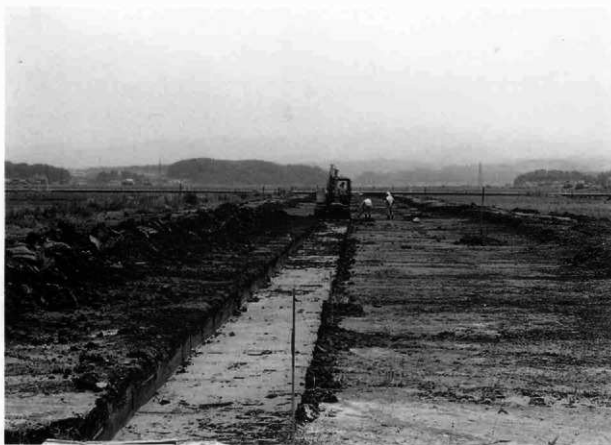
A地区上部層掘削作業（西方より）
