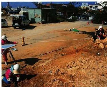
測量作業状況
