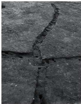
1. 溝4完掘状況（南東から）
