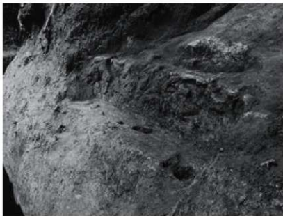
4 SI1貼床除去状況(南から)
