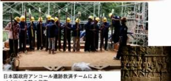
図 30 バイヨン寺院の版築による修復
