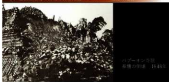
図 27 バパーオン寺院の基壇の倒壊
