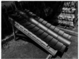
屋根原寸施工検討模型
