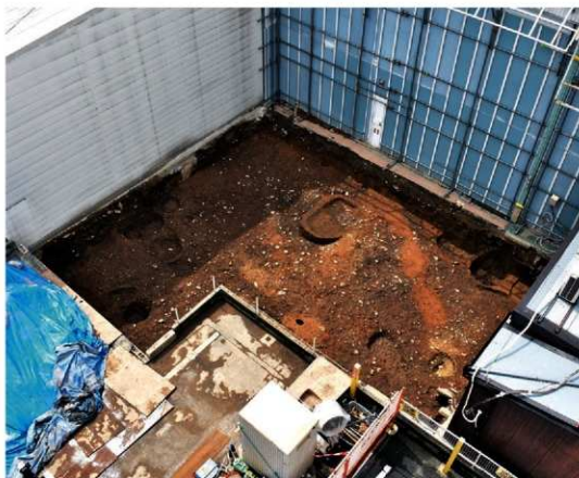
調査区全景（北東上方から）
