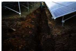
パネル前の浸透側溝
