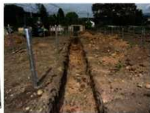
トレンチ5、6付近 (西より)
