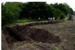
調査トレンチ全景（南西より）
