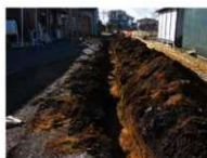
トレンチ2 (北より)
