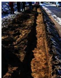
トレンチ 1 (北より)
