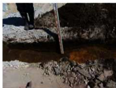
トレンチ 1 擁壁抜き取り痕跡
