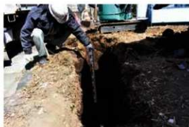
トレンチ (掘削深度)
