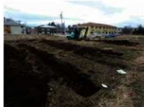
トレンチ1、2 (北東端より)
