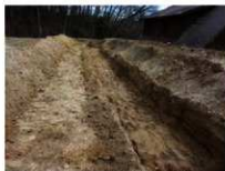
トレンチ (西より)
