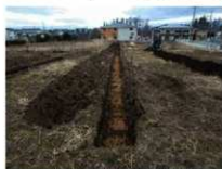
トレンチ3 (北より)
