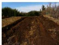
トレンチ1、2（東より）
