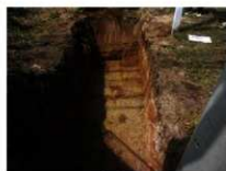
トレンチ全体 (西より)
