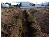
トレンチ 2 (西より)
