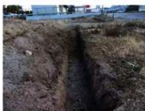
トレンチ 3 (西より)
