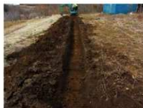
浸透側溝掘削状況②
