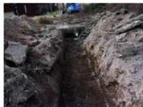
トレンチ 4 北側
