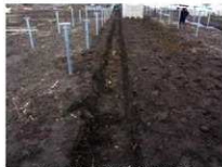
中央部付近浸透側溝
