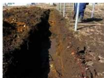
南端浸透側溝掘削状況
