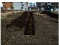
トレンチ7 (北より)
