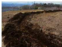
浸透側溝掘削状況①
