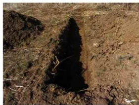
トレンチ掘削状況
