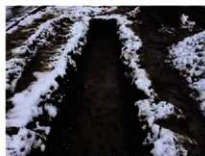
トレンチ掘削状況
