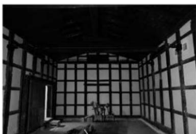
写2-4-16 米蔵 鉄骨プレース補強設置状況
