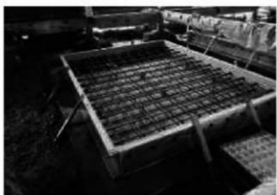
8 主屋 先打設基礎配筋状況
