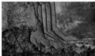
写2-4-36 米蔵 土壁の解体による塗り重ね確認状況
