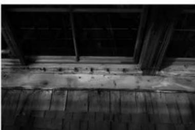
写真3-5-13 開口部下枠に縦格子用の掘り込み痕跡
