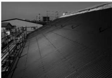
写2-4-30 覆屋 波型鉄板葺完了状況
