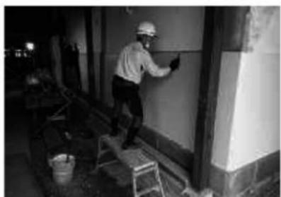
92 米蔵 外壁漆喰塗施工状況
