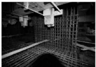
111 米蔵・文庫蔵 構造補強設置用コンクリート壁 配筋状況
