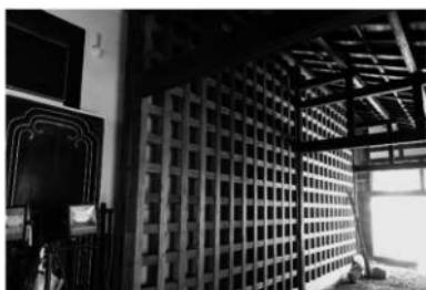
写2-4-17 覆屋 面格子補強設置状況
