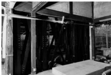
写2-4-15 主屋 鉄骨補強設置状況
