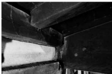
写3-2-8 大梁仕口腐朽状況
