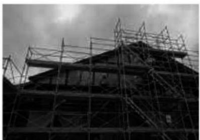
118 覆屋 構造補強構造用合板張施工状況
