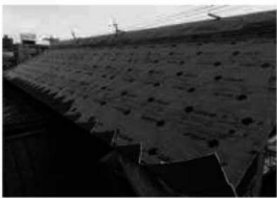
61 主屋 ガルバリウム鋼板葺施工状況
