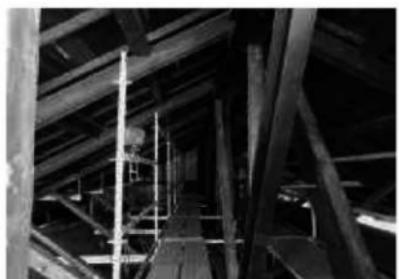
117 覆屋 構造補強鉄骨組立状況
