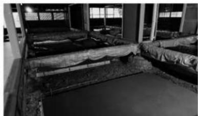
写2-4-12 主屋 先行打設範囲のコンクリート打設状況
