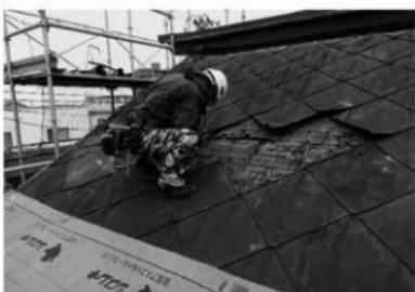
写2-4-28 主屋 下地補修状況（小羽葺・菱葺きが確認できる）
