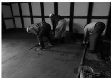
写2-4-40 米蔵 たたき風土間施工状況
