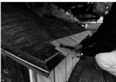
写2-4-33 主屋出窓 柿葺水切銅板と上目板
