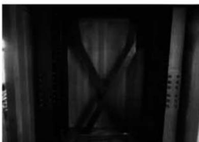
110 主屋 構造補強鉄骨組立状況
