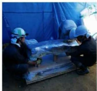
3. 取出した壁面の搬出状況
