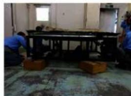
14. 【手順4-④】 左側壁取外し作業状況
