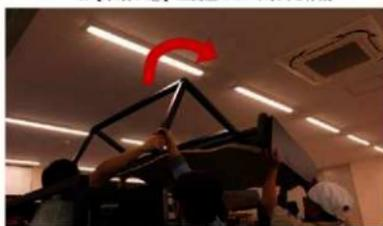
7. 【手順7-④】左側壁天井取外し作業状況2
