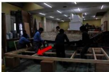
6. 【手順4】運搬用木枠固定作業状況1
