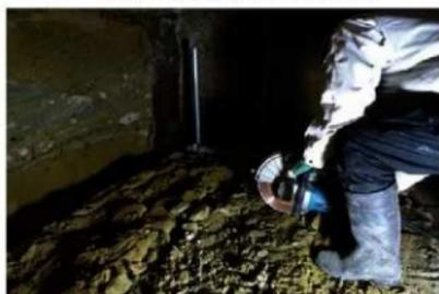
7. 工程 11 剥ぎ取り壁面の分割作業
