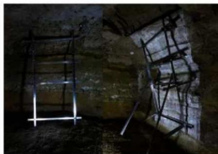
1. 工程6 受部の作成① フレーム作成・取付状況
