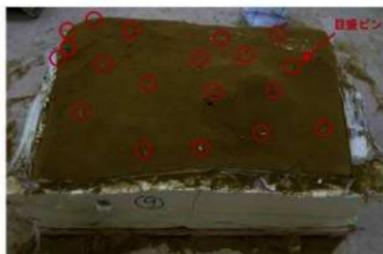
1. 【工程2】背面の削り出し・土除去作業前(壁番号㉔)
