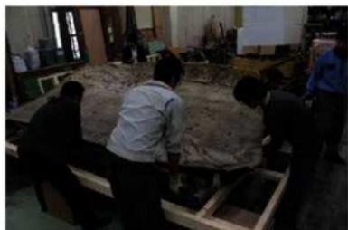
7. 【手順4】運搬用木枠固定作業状況2
