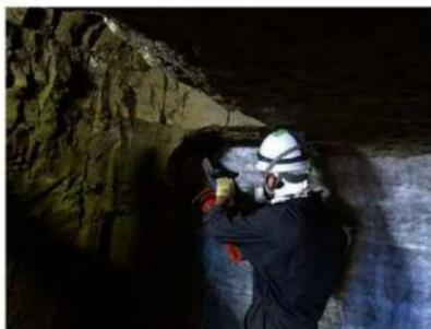
1. 奥壁左壁の掘削状況
