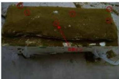
2. 【工程2】背面の削り出し・土除去作業前(壁番号㉕)
