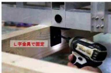
8. 【手順4】運搬用木枠固定作業状況3
