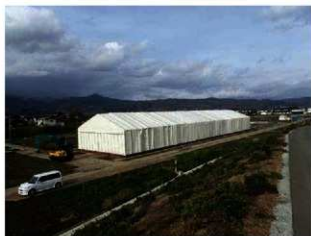
図8 大型テント設置
