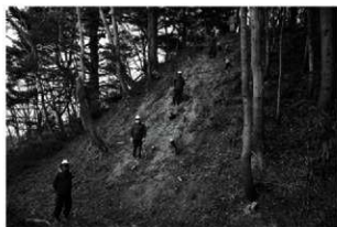
4. 鷺足館跡 平場1西側急斜面 現況（南から）
