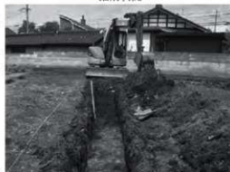
遺構出土状況
