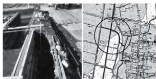
213 大奈良道跡12 中反田道跡群7 掘削状況・位置図
