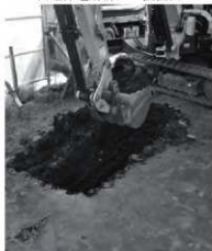
浄化槽設置箇所 掘削状況
