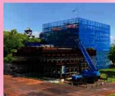
鉄骨構台設置後の戌亥櫓(令和4年5月17日)
