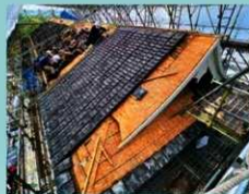
瓦葺き作業(令和4年8月22日)
