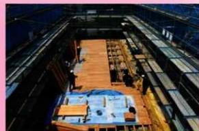
馬具櫓の解体保存工事状況(令和4年4月22日)
