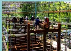
建て方作業(令和4年5月10日)
