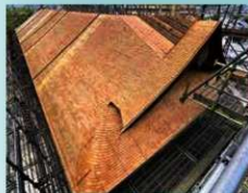
土居葺き完了(令和4年7月12日)
