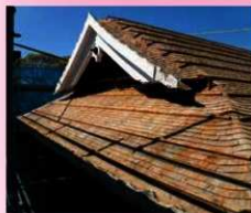
屋根瓦解体後の馬具櫓(令和4年4月5日)
