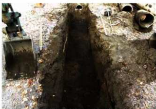
掘削工事北端 (南から)
