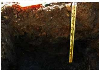
試掘坑南東壁（北西から）
