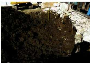
建物建設時に造成された深さ（南東から）
