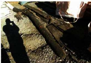
解体現場中央の地下から出土した木材
