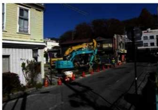
精進湯跡 建物解体現場（南から 奥の森が手長神社）
