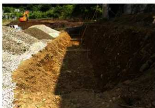
第2駐車場南壁部分 掘削後 (西から)
