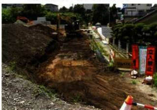
市道拡幅部分 掘削後 (北から)
