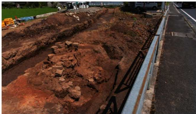
調査地全景（南から）
