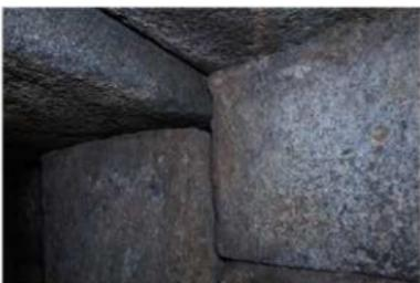
写真 02 前門・天井石・羨道側壁の組み方
