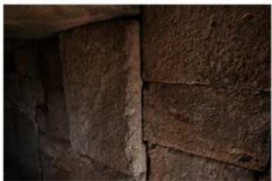
写真 03 前門のL字加工 (羨道右側壁上部)
