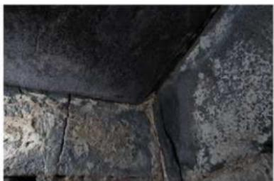
写真 15 漆喰残存状況⑦（玄室右側壁・玄門冠石・天井石隅角）天井石のL字加工部に漆喰が入り込む
