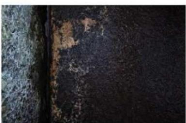
写真 41 漆喰の残存状況①（玄門右側門柱石）
