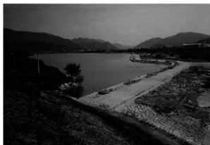
写真11 吉井堰 取水口付近 (西南から)
