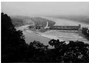
写真15 1992年に建造された堰（東から）
