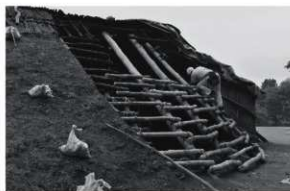
大型復元竪穴建物の修理作業
