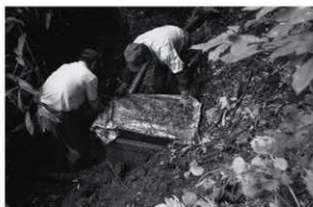
水場の設置「水路崩壊による修理作業」
