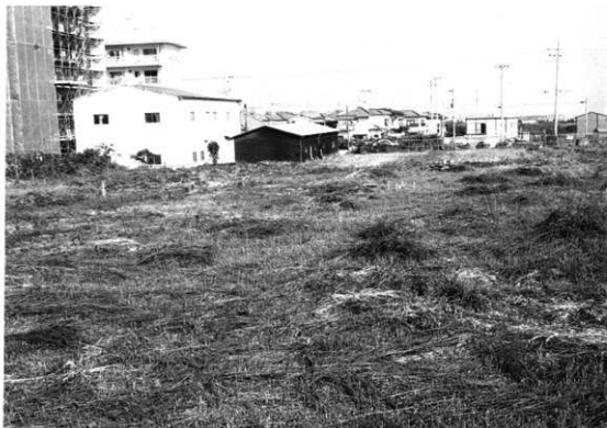
2 調査前全景（南から）
