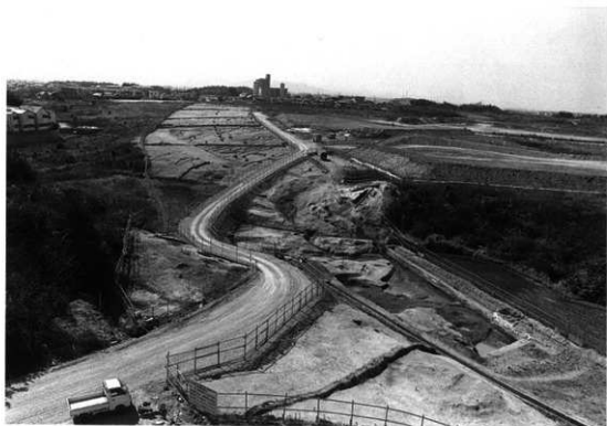
2 「西の谷」付近調査後の状況（北から）
