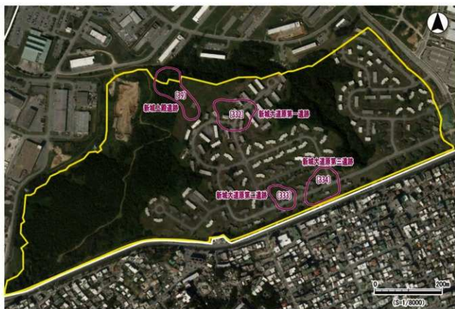
巻頭図版 3 返還前の西普天間住宅地区（平成 24 年度撮影）
