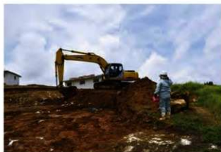
工区1表土掘削
