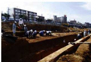
工区3 作業状況
