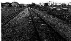
第249図版 引込線の現状（南西から） 2021年12月
