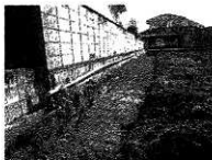
第239図版 東擁壁(北から)
