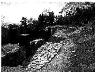
第55図版 南門跡 内側敷石の目地留め
