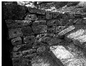
第54図版 南門跡 門道部西側の石垣 左：施工前 右：施工後
