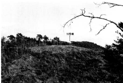
2. 10号墳遠景 (西から)
