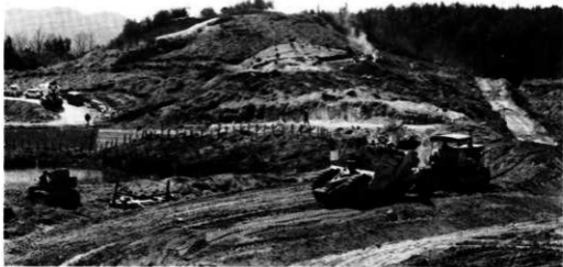
1. 掘り上がり後の遠景（北から）
