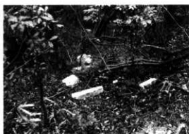
第34図版 築石転落状況
