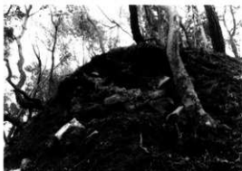
2. 崩壊後の石垣
