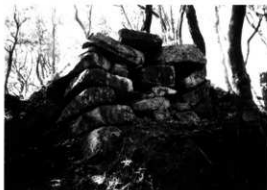
1. 崩壊前の石垣
