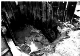
第11図版 掘削部（南東から）
