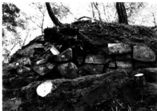
第33図版 石垣検出状況（北から）
