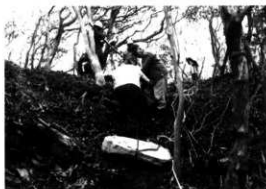
第38図版 築石の引上げ作業
