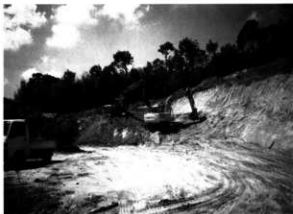
第16図版 工事状況
