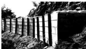
第37図版 列石・敷石転落防止木柵
