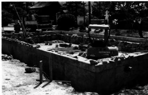
第1図版 工事状況
