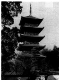
平成の大修理が終った 備中国分寺五重塔
