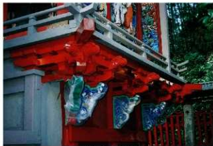
修復作業中の冠稲荷神社本殿
