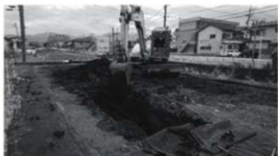
写真8 重機による埋め戻し作業 (T 14)
