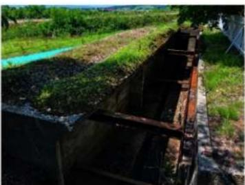
図54. 一巳村分会小銃射撃場監的壕(深川市市指定文化財「監的壕」)掩蓋形状から、回転式と推定される。排水溝は中央に位置する。内部のH鋼は近年の補強。
