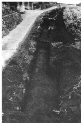
②区、③区掘削状況 (西より)
