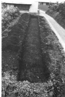
④区掘削状況 (東より)
