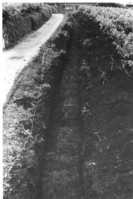
①区掘削状況 (西より)
