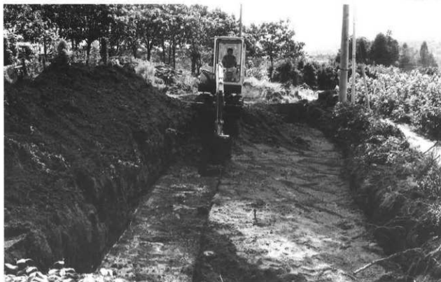
B区掘削風景 (西より)
