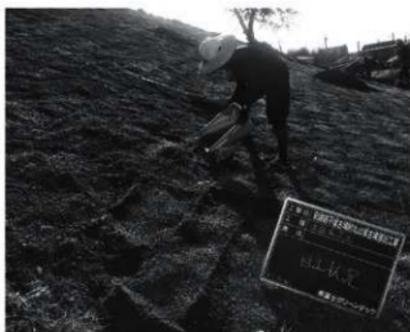
写真19 目土施工の様子
