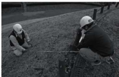
写真36 起工測量の様子
