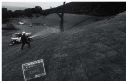
写真25 灌水養生工の様子
