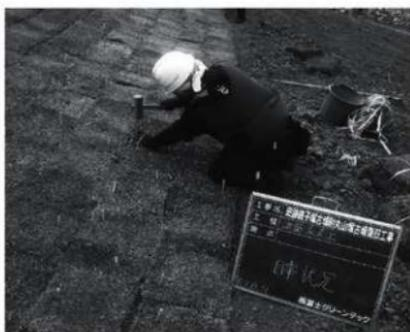
写真20 目串施工の様子
