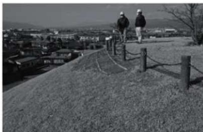
写真48 植生マット工完了2
