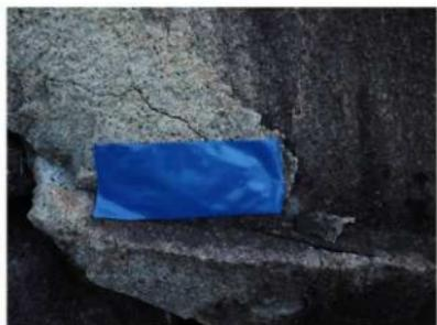
写真5-1-8 変状の例「剥離」：除去
