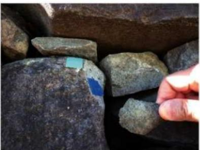
写真5-1-9 変状の例「剥離」：存置
