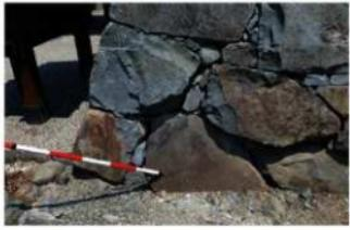
写真4-1-13 割れ(亀裂)の代表例
