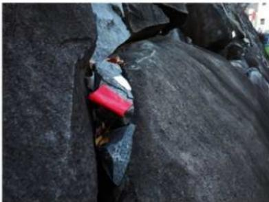
写真5-1-10 变状の例「浮石」：除去
