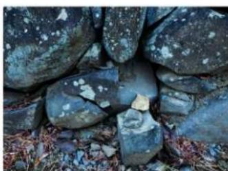
写真4-2-9 割れの進展による築石の崩壊
