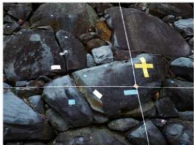
写真5-1-6 変状の例「孕み出し」
