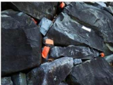
写真5-1-12 变状の例「浮石」：叩締
