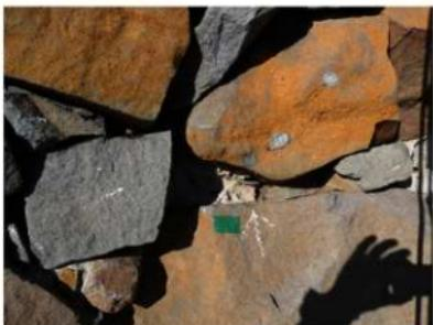
写真5-1-13 变状の例「欠落」
