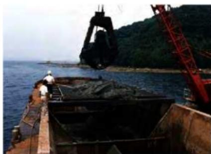
図4-2-2 バケット付き台船を利用した掘削の例（鹿島海底遺跡）
